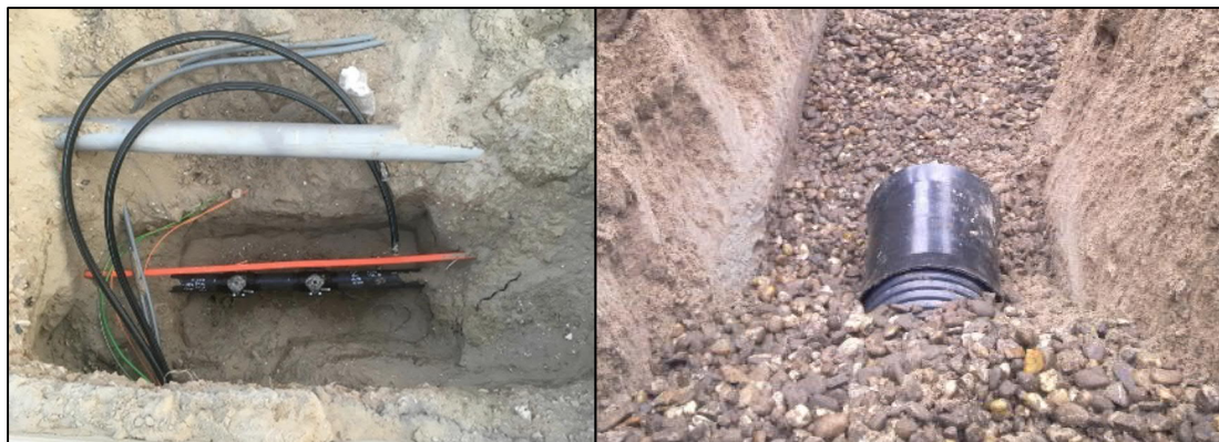
Figuur 2: Bestaande kabels en leidingen links en omstorting rondom AGWP-leiding rechts (bron: Wareco)
